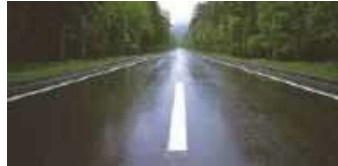
Para carreteras en mal estado
